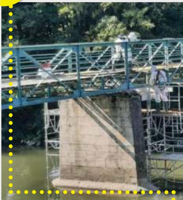
Après avoir sécurisé le périmètre et certains piliers de soutènement, les équipes présentes sur le chantier ont procédé à la découpe de l'ancien ouvrage en deux parties pour faciliter son enlèvement grâce à une grue. L'armature métallique a été récupérée, découpée, dépolluée et refondue pour être valorisée.
